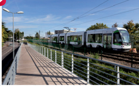
Tram ligne 1 - Arrêt Souillarderie
